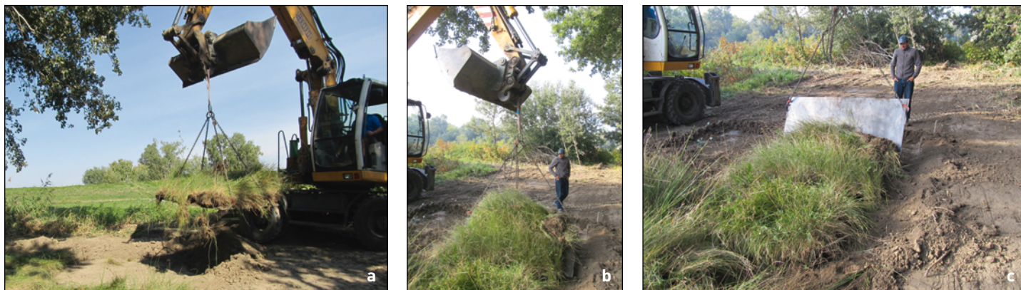
Figure 4. (a) Pelle mécanique récupérant une plaque métallique; (b) dépôt au sol; (c) glissement de la plaque de sol à terre
