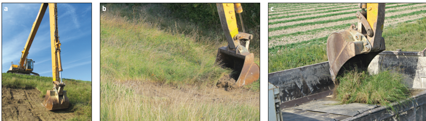
Figure 3. (a) Pelle mécanique disposée au sommet de la digue ; (b) prélèvement de la plaque de sol ; (c) dépôt des plaques de sol sur des plaques métalliques
